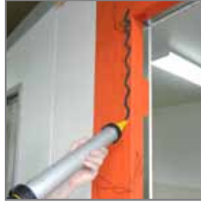
10. Usando la pistola de silicona aplique un cordón de VaproLiqui-Flash siguiendo un patrón de zigzag, en el muro alrededor de la abertura.
