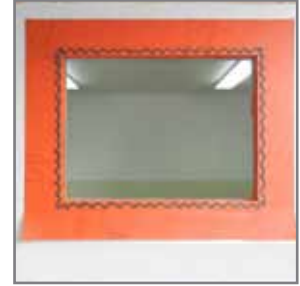
10. Usando la pistola de silicona aplique un cordón de VaproLiqui-Flash siguiendo un patrón de zigzag, en el muro alrededor de la abertura.
