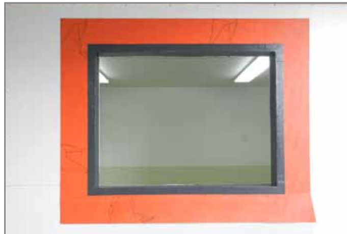
Instalación completa de todas las superficies de una abertura, con VaproLiqui-Flash.
