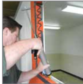
12. Aplique cordones adicionales de VaproLiqui-Flash siguiendo el patrón de zigzag, en todas las caras interiores de la abertura.
