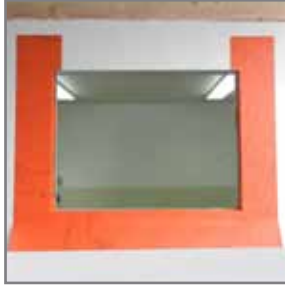
8. Instale el tapajuntas del dintel solo después de haber instalado las jambas y tenerlas completamente pegadas.
