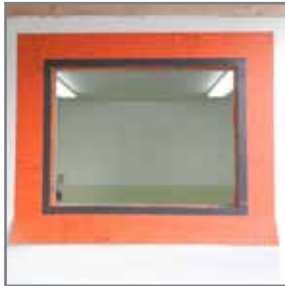
11. Inmediatamente esparza el material aplicado con la espátula (de preferencia plástica), creando un borde de 1" de ancho alrededor de la abertura.
